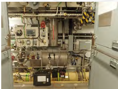
Überprüfung der Schadstoffbelastung in den Betriebsräumen Schiffen und Booten (F125)
