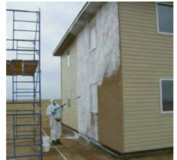
Dekontamination von Infrastruktur
