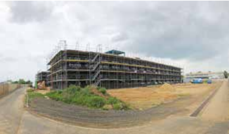
Das neue Lehrsaalgebäude (Gebäude U21) Quelle: OMaat Özdogan v. 06.05.2019
