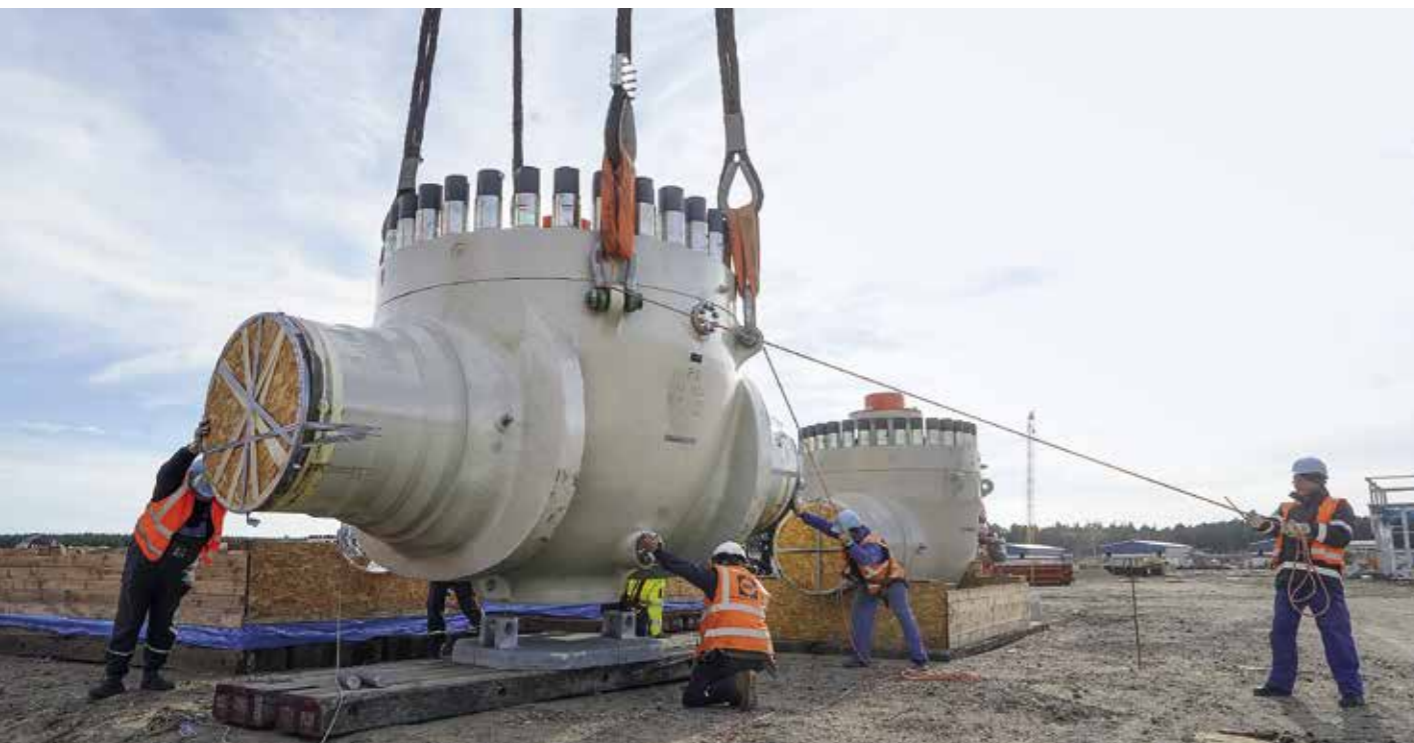
Bringt die Ostseepipeline neben russischem Gas auch Probleme nach Deutschland? Arbeiter setzen an der Empfangsstation von Nord Stream 2 in Lubmin (Mecklenburg-Vorpommern) ein 100 Tonnen schweres Absperrventil auf sein Fundament
