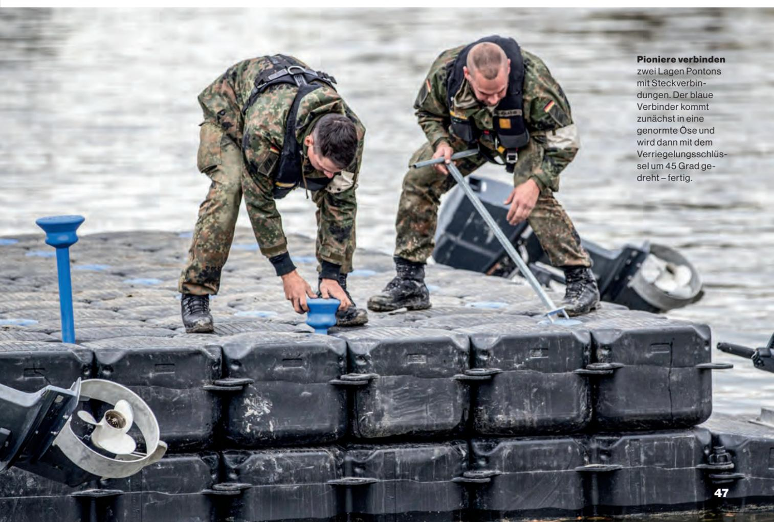
Pioniere verbinden zwei Lagen Pontons mit Steckverbindungen. Der blaue Verbinder kommt zunächst in eine genormte Öse und wird dann mit dem Verriegelungsschlüssel um 45 Grad gedreht – fertig.
