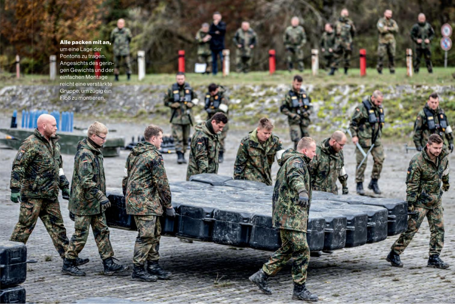
Alle packen mit an, um eine Lage der Pontons zu tragen. Angesichts des geringen Gewichts und der einfachen Montage reicht eine verstärkte Gruppe, um zügig ein Floß zu montieren.
