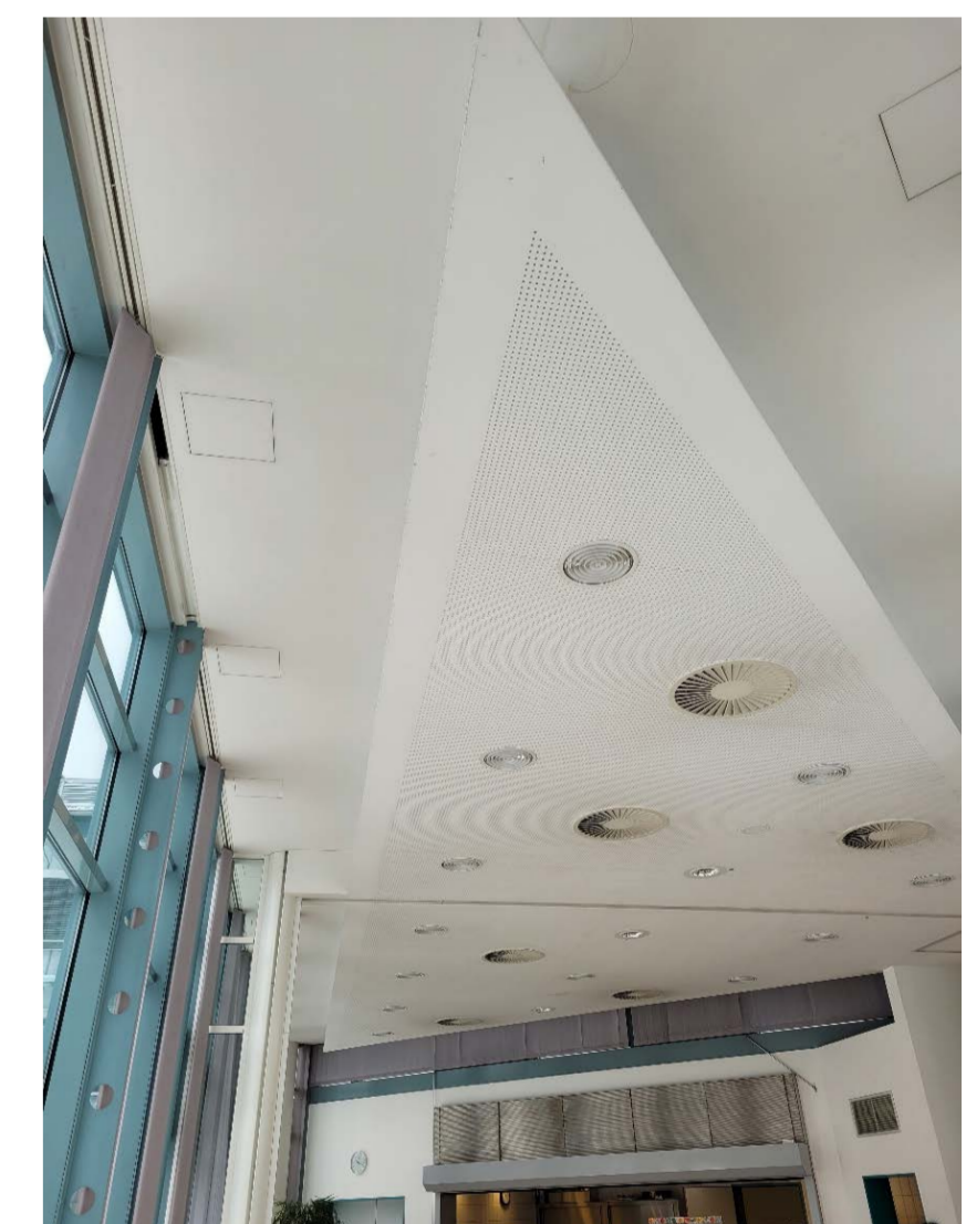
Abgehängte Lochdecke (Raum 0.216/0.217)
