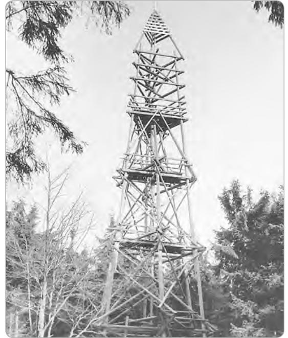
► **Abb. B-4-56:** Auf dem Stegskopf im Truppenübungsplatz Daaden hatte Topographiebatterie 301 einen Vermessungsturm gebaut und pflegte gute Beziehungen zur TrÜbPl-Kommandantur, um 1970 (Quelle: Landmann)
