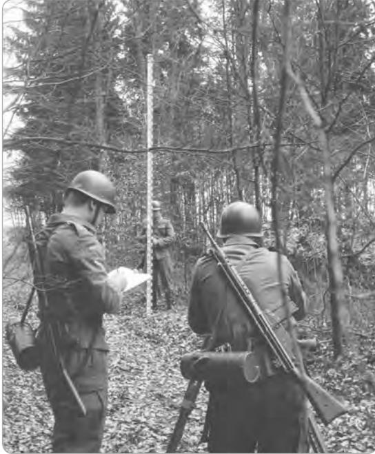
► **Abb. B-4-36:** Vermesser beim Nivellement (Quelle: Barner)
