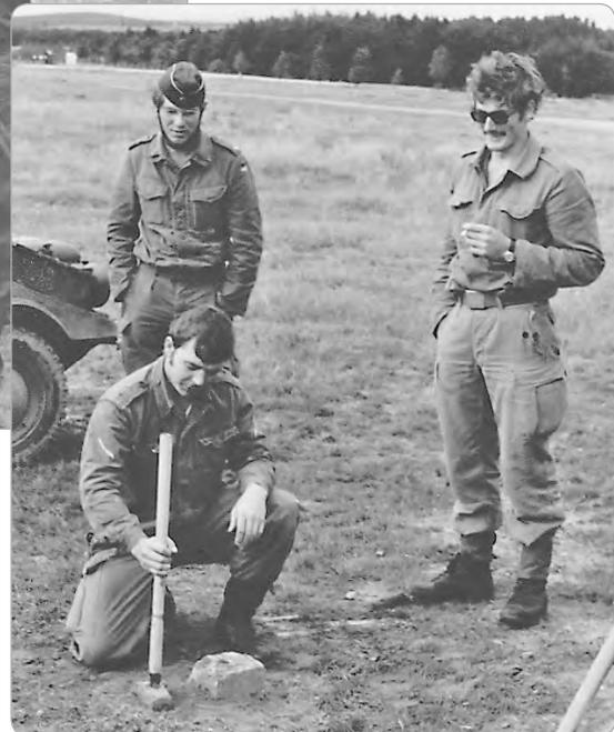
► **Abb. B-4-61 bis B-4-63:** StUffz Lang (M.) beobachtete die Richtungen zu Vermessungspunkten, die zum Teil mit Schnell-signal (l.) signalisiert waren, während Lt Brender (r., mit Schiffchen) mit den Signalhochbauern MP-Pfeiler setzte, Sommer1972 (Quelle: Landmann)
