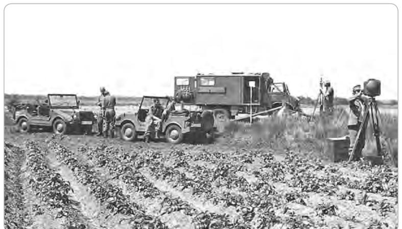
► **Abb. B-2-16:** Vermessungen mit Theodolit und Tellurometer MRA 3 (rechts) während der Vorbereitung für die Vermessungsübung NORD-PFEIL 1969 des Korps-Artilleriekommandeurs 1
