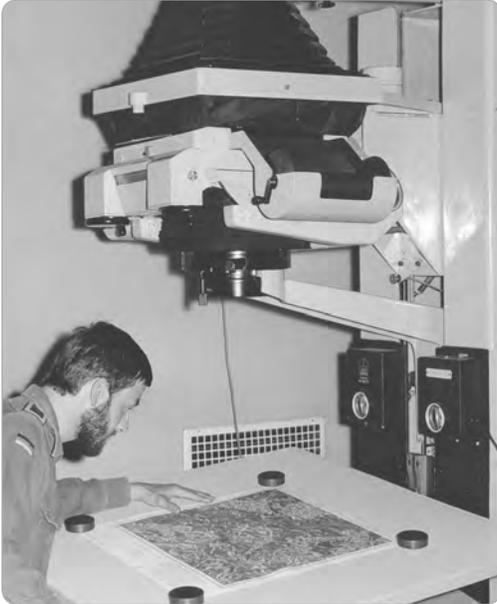
▶ **Abb. B-5-64:** Arbeit am Luftbildentzerrungsgerät Zeiss SEG V b, StUffz Wittig, 1979. (Quelle: Landmann)
