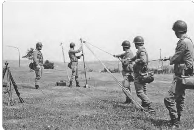
Abb. B-5-59: Der Steckmast wurde mit Flaschenzug aufgerichtet, links Fw Heim;
