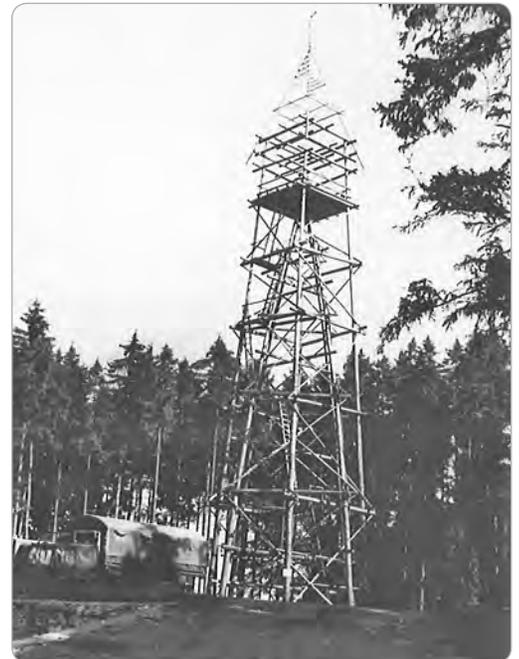
► **Abb. B-3-11:** Topographiebatterie 201 baute auf dem Truppenübungsplatz Heuberg einen Vermessungsturm mit 25 m Signalthöhe, etwa 1965. (Quelle: Pierau)
