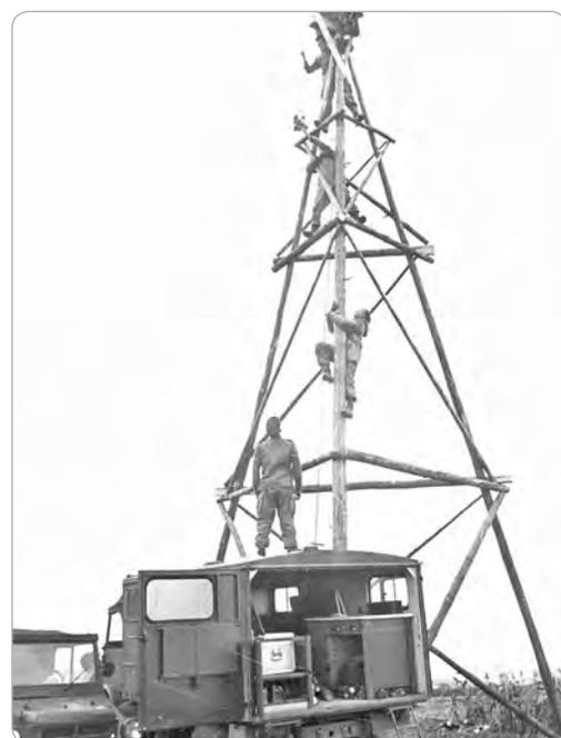
► **Abb. B-3-13:** ... mit dem Bau von Signalgerüsten. (Quelle: Heinrich)
