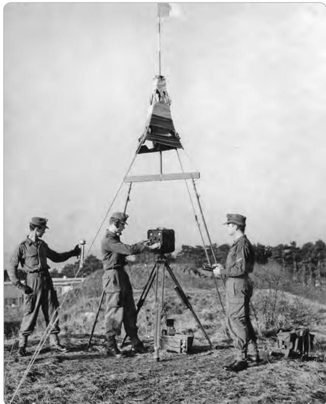
► **Abb. B-3-15:** Vermessungstrupp unter einem Schnellsignal bei der elektronischen Entfernungsmessung mit Tellurometer MRA 3, links Temperaturmessung mit Aspirationspsychrometer, um 1967 (Quelle: TopBttr 850)
