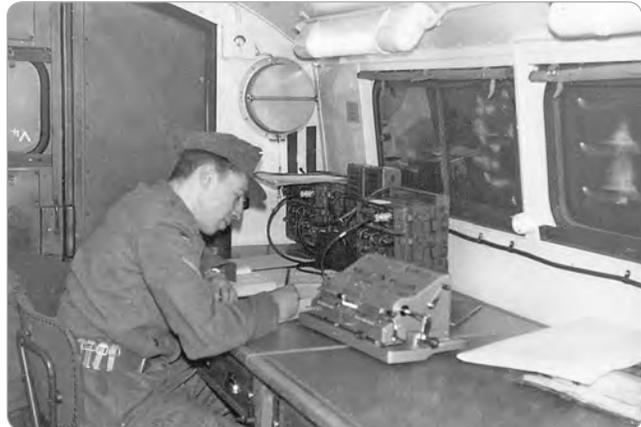
► **Abb. B-4-40:** Vermessungsauswerter mit Brunsviga Doppel-Rechenmaschine D18R und Funkempfänger für Zeitzeichen (Quelle: Barner)
