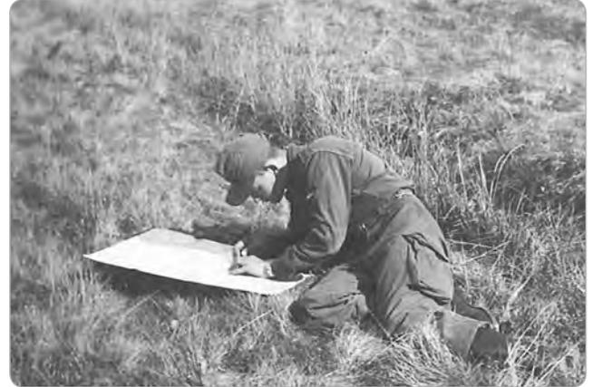
► **Abb. B-4-4 und B-4-5:** Vermesser der Korps-Topographiebatterie 697 mussten 1958 auf dem Truppenübungsplatz Schwarzenborn beim Wiederherstellen eines Trigonometrischen Punkts die unterirdische Vermarkung freilegen (links), während der Vermessungstruppführer das Feldbuch führte (rechts) (Quelle: Pierau)
