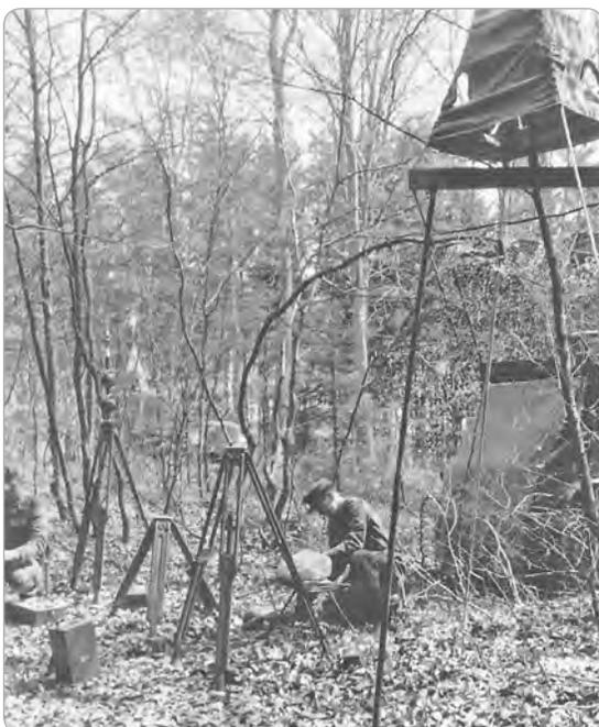
► **Abb. B-4-38:** Vermesser mit Signalisierungsgeräten: Trig-Scheinwerfer (links), Schnellsignal (rechts) (Quelle: Barner)
