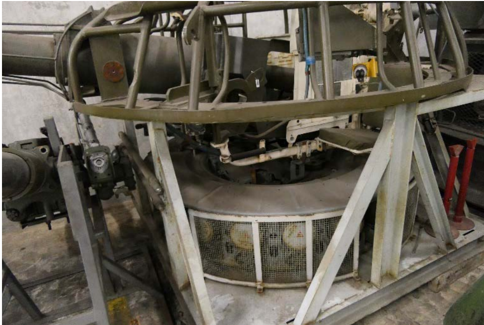
Abbildung 2: Die Munitionstransportbühne unterhalb des Panzerturms
