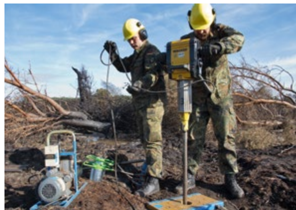
△ Abb. 2: Aufschlusssondierungen im Moor Meppen. (Quelle: Dezernat Einsatzgeologie)
