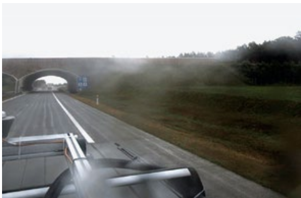
△ Abb. 8: Bild der Frontkamera eines Fahrzeuges mit GeoInfo-Sensor bei der Anfahrt auf eine zu vermessende Brücke. (Quelle: ZGeoBw)
