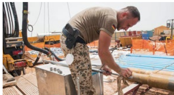
△ Abb. 4: Brunnenbohrarbeiten durch Geologen des GeolInfoDBw. (Quelle: Bundeswehr/Stefan Voges)
