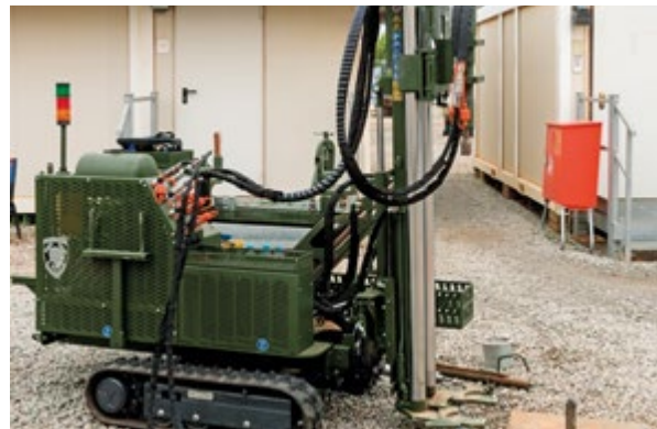
△ Abb. 6: Sondierdraupe für ingenieurgeologische Erkundungen. (Quelle: ZGeoBw)
