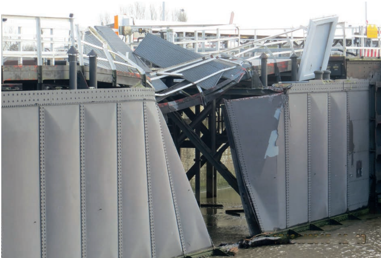
Zerstörtes Schleusentor in Brunsbüttel nach einer Havarie im Januar 2015
