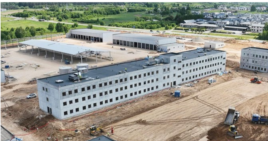
↑ Eine derzeit im Bau befindliche Kaserne des litauischen Kampftruppenbataillon am Stadtrand von Vilnius dient als mögliches infrastrukturelles Vorbild für die Kräfte der Deutschen Brigade.
