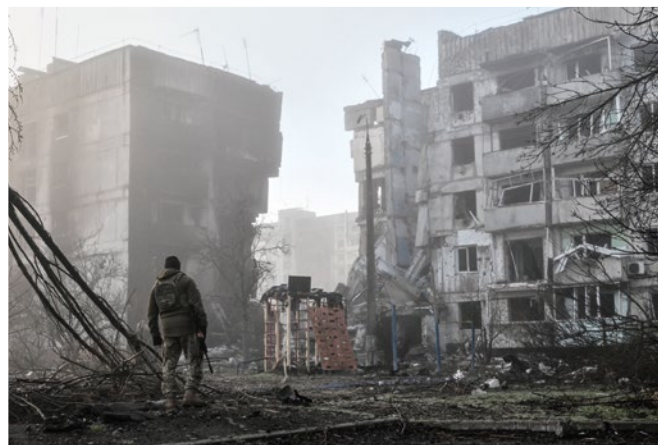
↑ Ein Soldat steht in Orichiw (Region Saporischschja), wenige Kilometer von der Frontlinie entfernt, vor durch russischen Beschuss beschädigten Wohnhäusern. Russische Truppen beschießen die Stadt täglich mit Gleitbomben und Kampfdrohnen. Mehr als 90 Prozent der Infrastruktur wurden dort zerstört.
