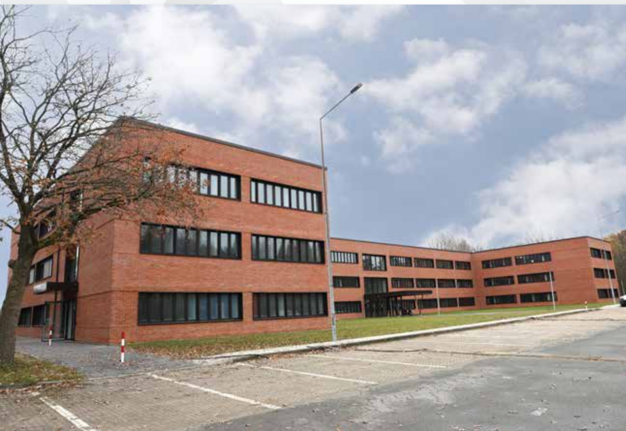
Unten: Fertigstellung des neuen Bürogebäudes 336A im November 2021
