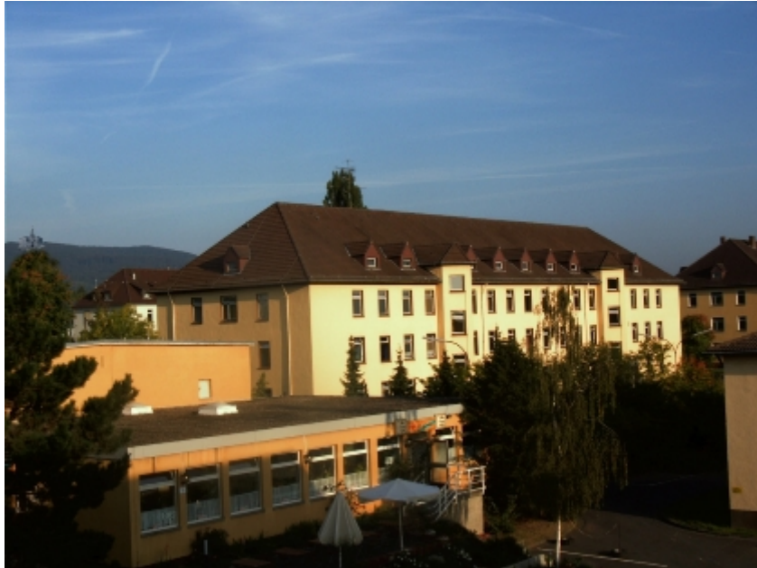
Unterrichtsgebäude der Bundeswehrfachschule Kassel (Quelle: BiZBw)
